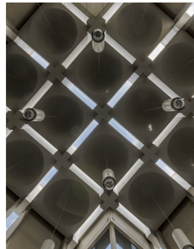
In het ontwerp komen veel vierkanten en cirkels voor. De dakconstructie bestaat uit vierkante betoncassettes met verdiepte bollen. Licht valt binnen door de glazen stroken tussen de cassettes.
