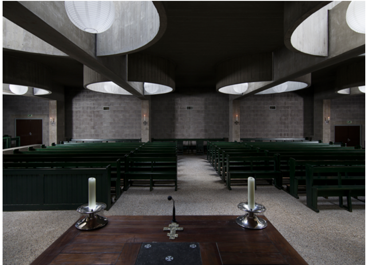
De ruimte voor de eredienst ligt haaks op de Via Sacra. De groene banken zijn gericht naar het altaar terwijl het daglicht de ruimte binnenkomt via ronde kokers in het betonnen plafond.
