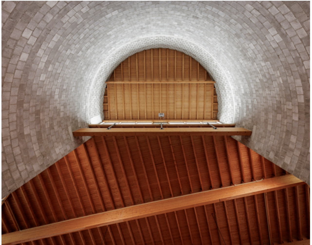
Zicht omhoog in een van de torens. De wand bestaat uit betonsteen, het plafond uit houten planken. Net onder de zoldering is een lichtstraat aangebracht.
